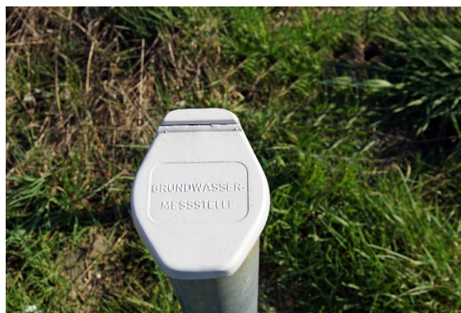
Grundwassermessstelle. Foto: brudertuck69/stock-adobe.com.
